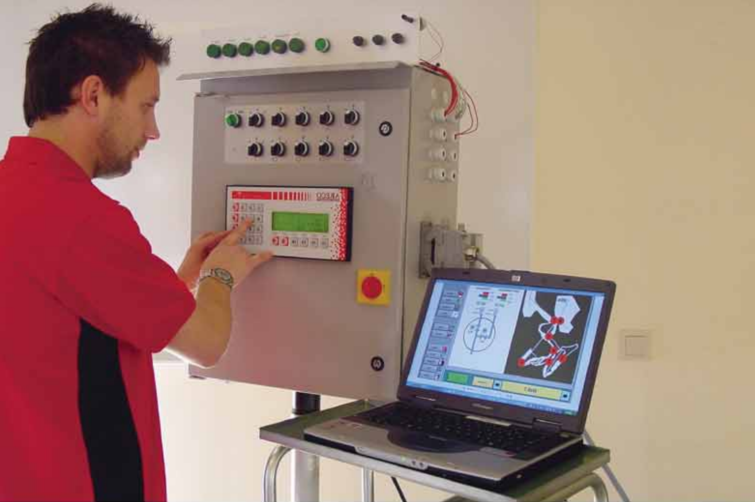
Снежный «дизайнер» инженер Л. Вярмефорш из ARECO Supersnow настраивает узлы автоматизации оснеживания
